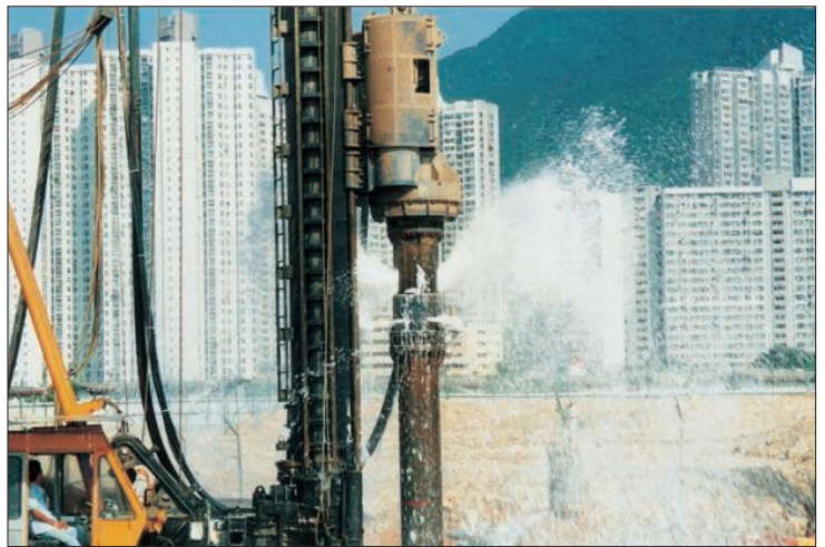
基礎杭 ビルなどの建造物や橋梁の基礎工事で口径32" (φ800)まで使用されています。
